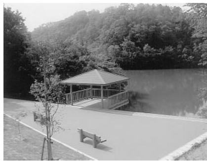
青野ダム公園（東屋）
