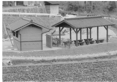
明治池公園（トイレ・東屋）
