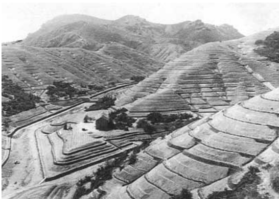
治山事業施工
