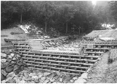
木製治山ダム全景
