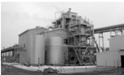
バイオマス発電施設
