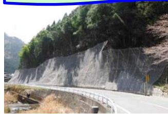
【道路防災】 国道 429号(美作市)
