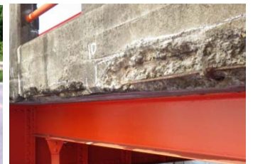
【③橋梁補修(老朽化)】 国道 486号(新栄橋側道橋・矢掛町)
