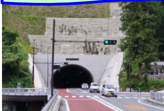
【道路改築】 県道 新見川上線(新見市)
