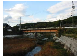
【⑥橋梁耐震化】 県道 和気笹目作東線 (門尻橋・美作市)
