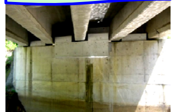
【橋梁耐震化】 県道 高梁御津線(境橋:吉備中央町)
