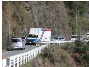
【④幅員狭小】 国道 429号(美咲町・吉備中央町)
