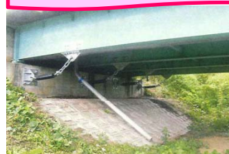
【橋梁耐震化】 県道 津山柳原線(鷺橋:美咲町)
