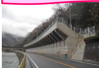
【道路防災】 国道180号(新見市)
