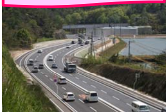
【道路改築】 国道429号(倉敷市・総社市)
