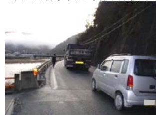
【④幅員狭小】 県道 新見川上線(新見市)
