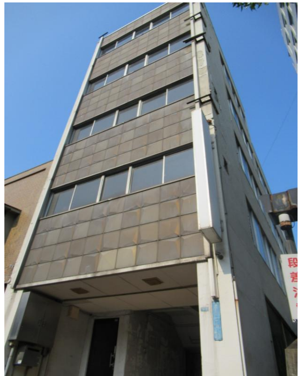
南西方より撮影
