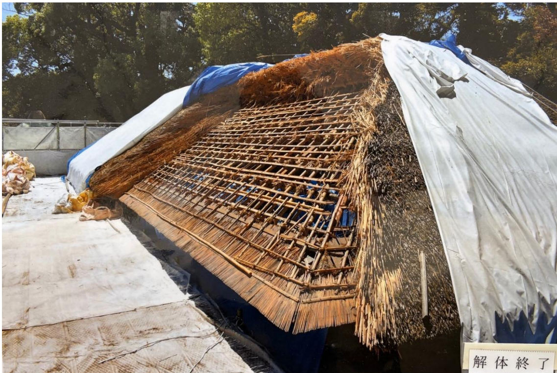
弓場施工状況
