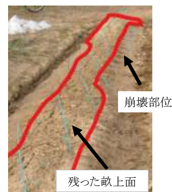
図1 畝の崩壊部位
