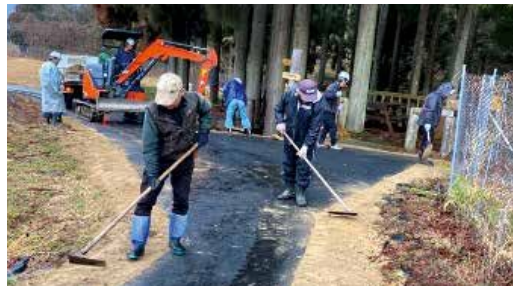
長寿命化（農道のアスファルト舗装）
