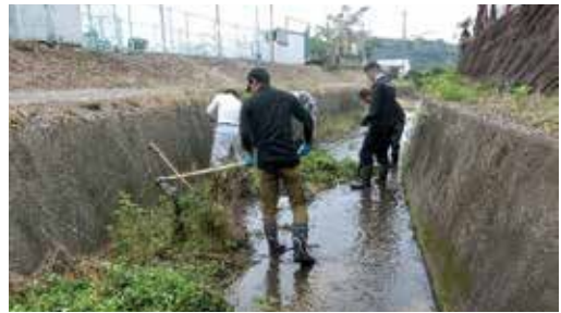
水路の泥上げ
