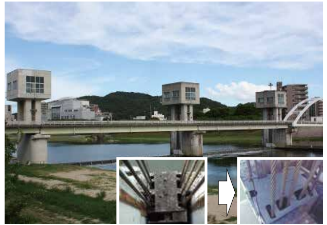
新堰地区（岡山市）【ワイヤーロープ等の更新】
