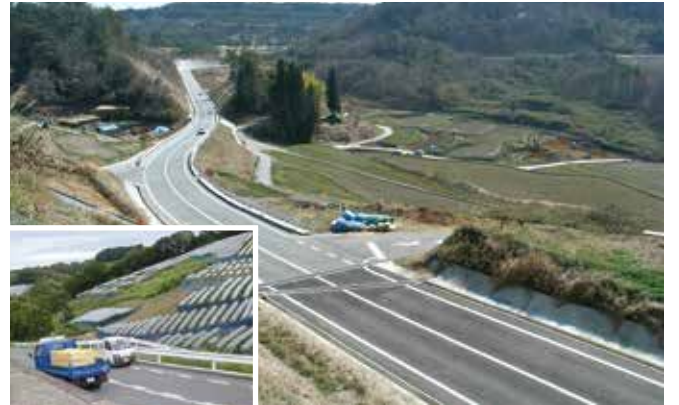
広域農道 備前東部2期地区（和気町）
