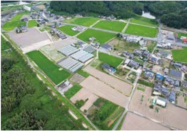
建部地区 吉田工区（岡山市）
