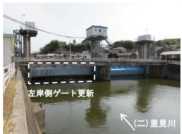
昭和水門 左岸側ゲート更新
