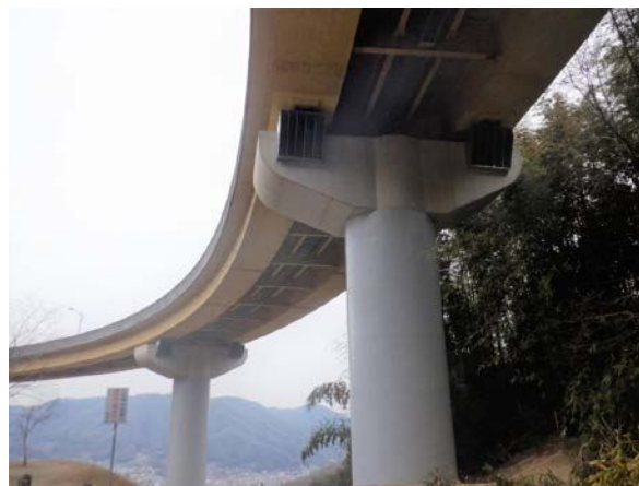
国道 484 号 愛宕ループ橋 落橋防止工
