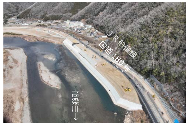
施工状況（作原地区）
