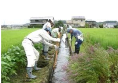
水路の泥上げ
