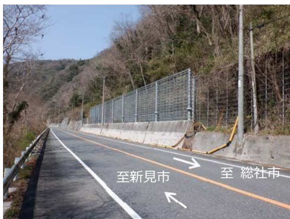
国道180号（新見市）落石防護工
