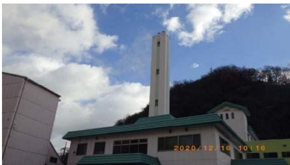
(ばい煙発生施設)
