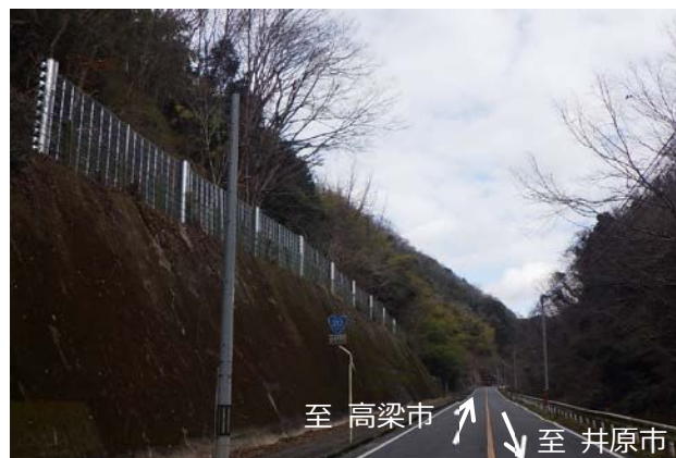
国道313号（井原市）落石防護工
