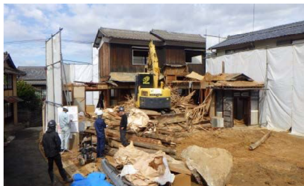
解体現場への立入検査
