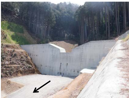
施工状況（猿木谷川）
