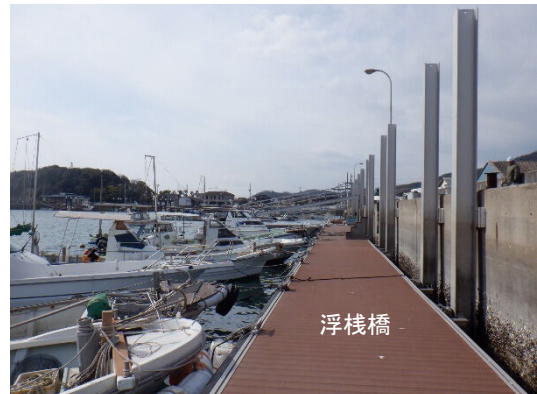
沙美漁港（浮棧橋の更新）
