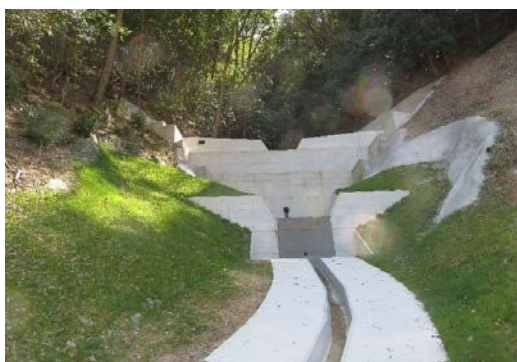
溪間工（治山ダム）による土砂流出の抑制
