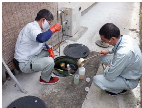
(浄化槽の使用状況の確認)
