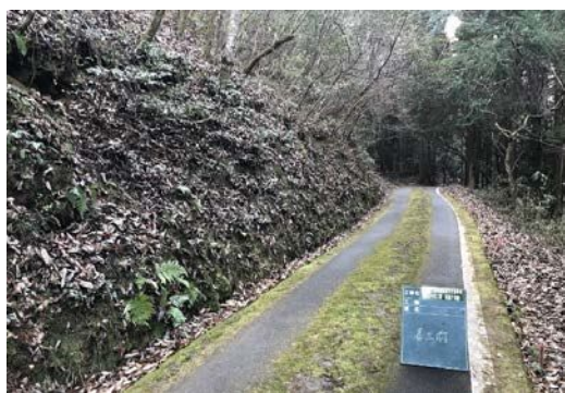
林道法面の改良による走行安全性の確保（改良前）
