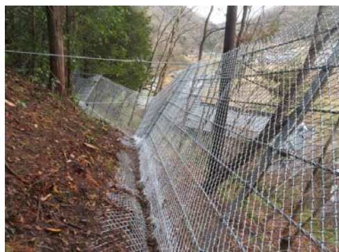
山腹工（落石予防工）による落石の危険の防止
