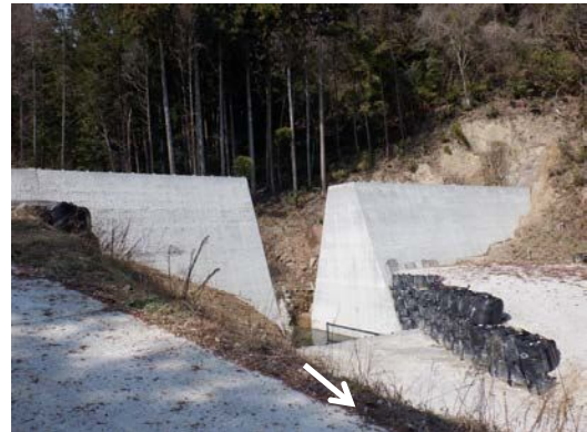
施工状況（太田谷川）
