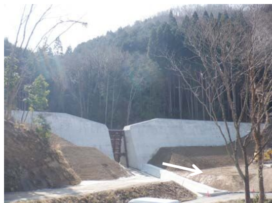
施工状況（小岸谷川）
