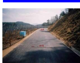
農地に隣接した農道整備
