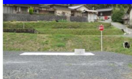
防火水槽の設置
