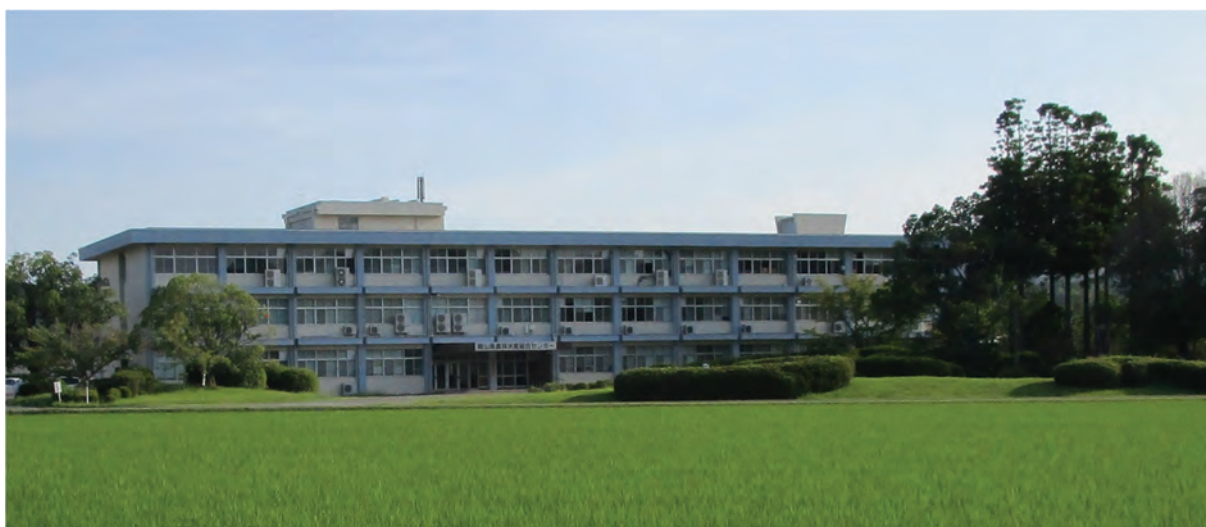
農業研究所本館正面より
