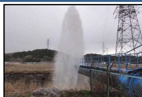
水管橋空気弁からの漏水 (福島県)
