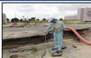
共同溝の不同沈下 (茨城県)
