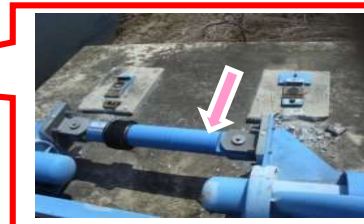
水管橋支承部の破断と横ずれ (宮城県)
