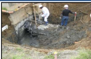
構造物接続部の配管離脱状況 (茨城県)
