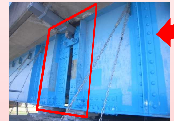
補修後(朽端部補修<部材取替>)
