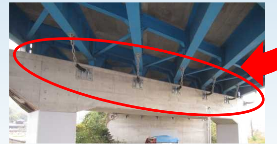
耐震補強後(落橋防止チェーン設置)
