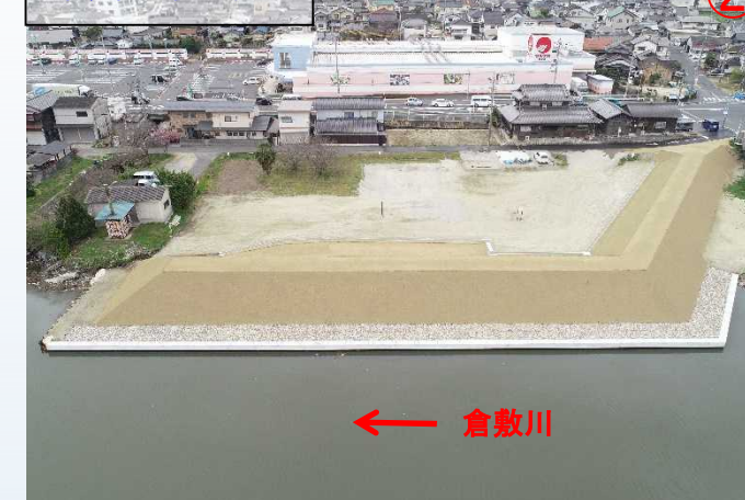
築堤施工後の状況
