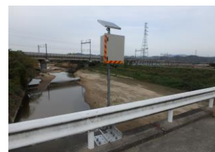
危機管理型水位計の設置状況
