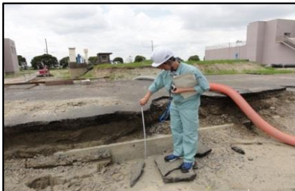
共同溝の不同沈下(茨城県)
