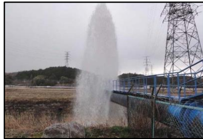
水管橋空気弁からの漏水(福島県)
