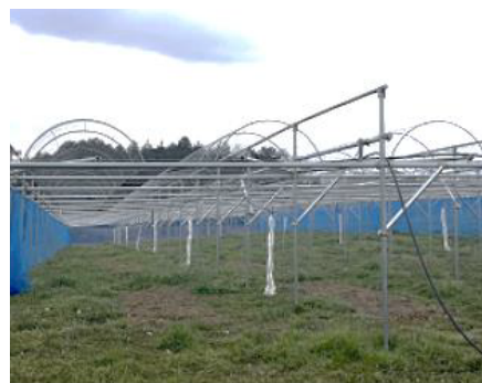
簡易被覆・果樹棚(ハウス移行型) 約430万円/10a ※ハウス化には+800~1,000万円必要
