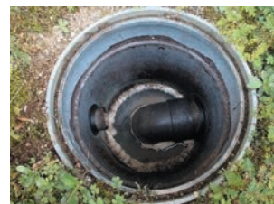
写真（台所排水マス）
