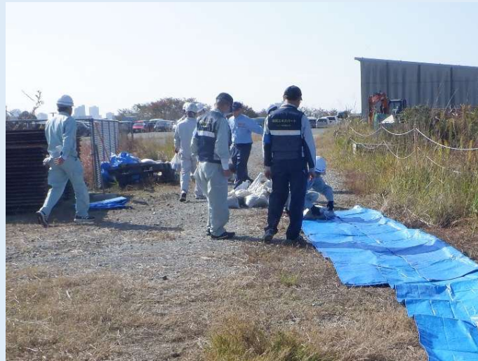
改良積み土のう工法
