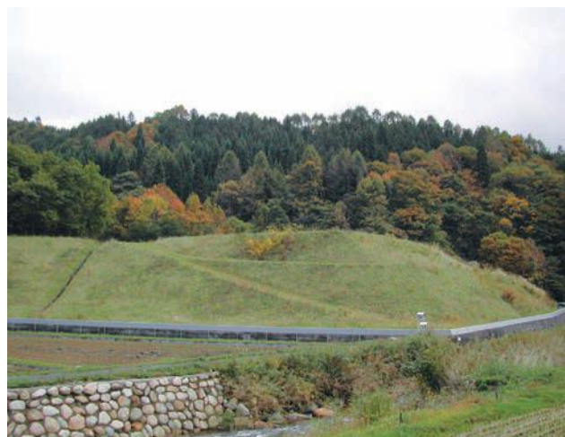
中津河大切坑捨石堆積場
