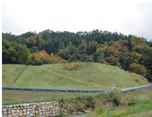
中津河大切坑捨石堆積場
