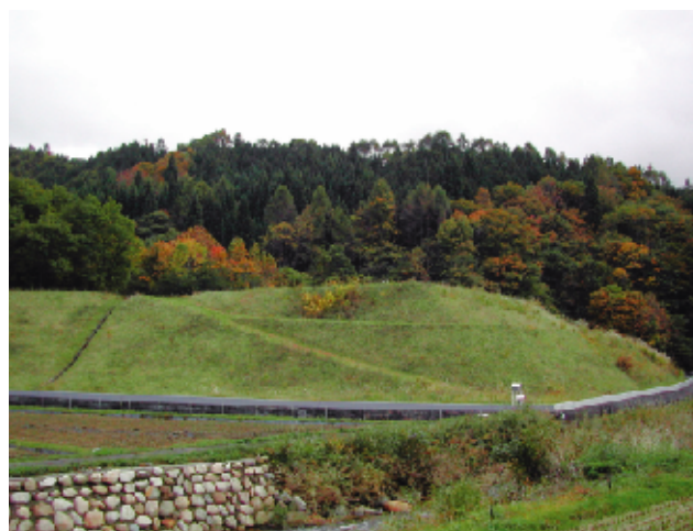
中津河大切坑捨石堆積場
