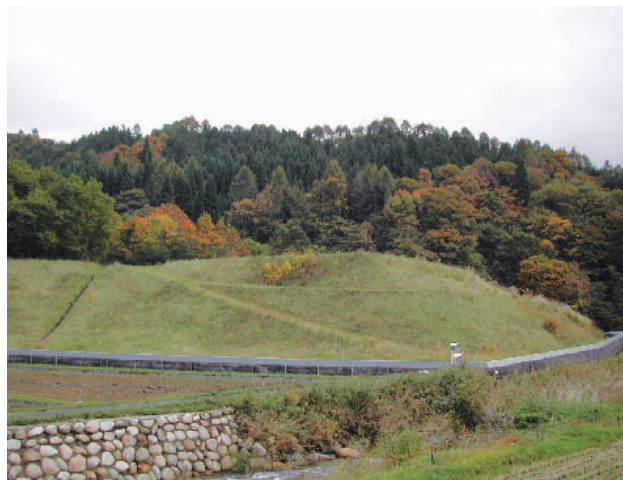
中津河大切坑捨石堆積場
