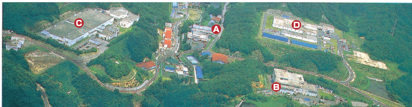
上(写真) 人形峠環境技術センターの全景 A 総合管理棟、開発試験棟、B 製錬転換施設、C 濃縮工学施設(旧ウラン濃縮パイロットプラント)、D ウラン濃縮原型プラント
