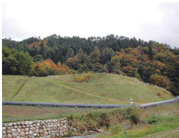
中津河大切坑捨石堆積場
