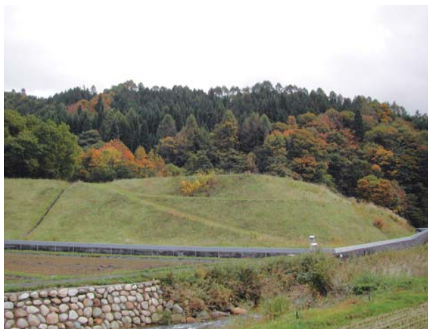
中津河大切坑捨石堆積場
