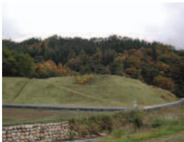
中津河大切坑捨石堆積場
