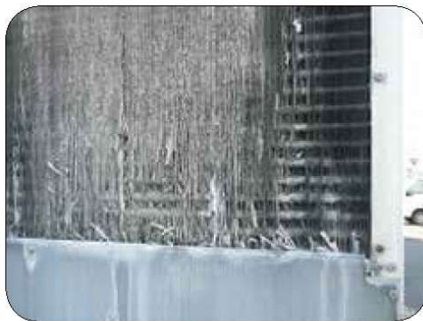
熱交換器の劣化
