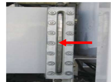
冷媒液面の低下
