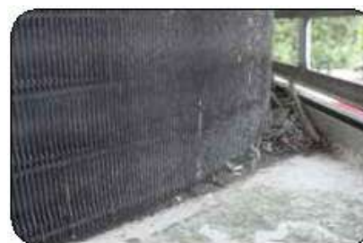
熱交換器下部の腐食
