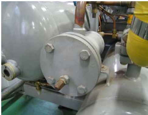
④ 機械式継手とフランジ
