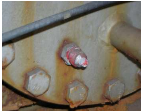
⑤ 溶栓と安全弁（高圧保護）
