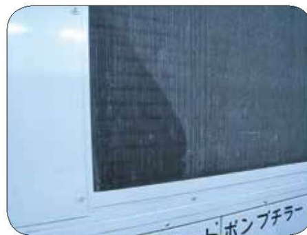
熱交換器の劣化
