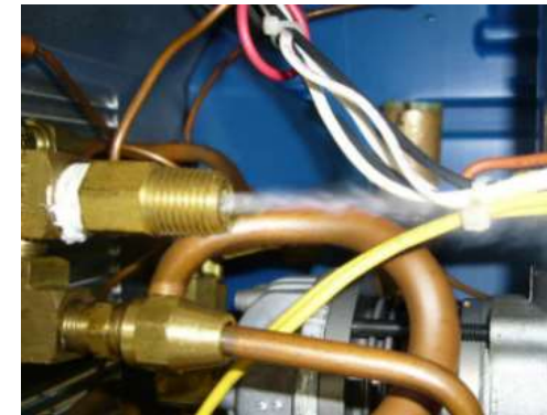
⑤ 溶栓と安全弁（高圧保護）
