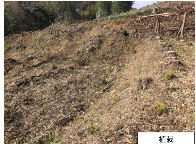
現場協議(地拵え状況等)
