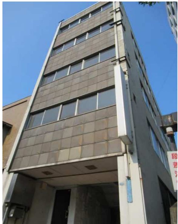
南西方より撮影
