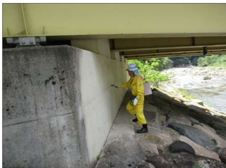
打音点検状況（橋台）
