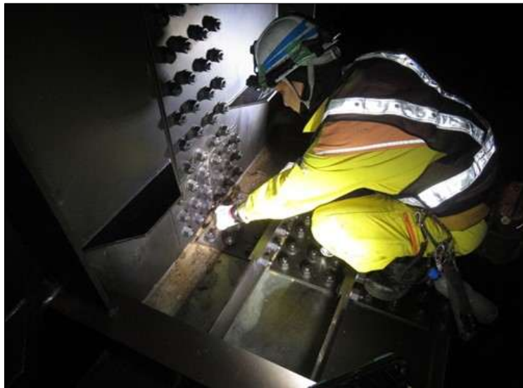
ボルト触診状況（橋梁箱桁内部）
