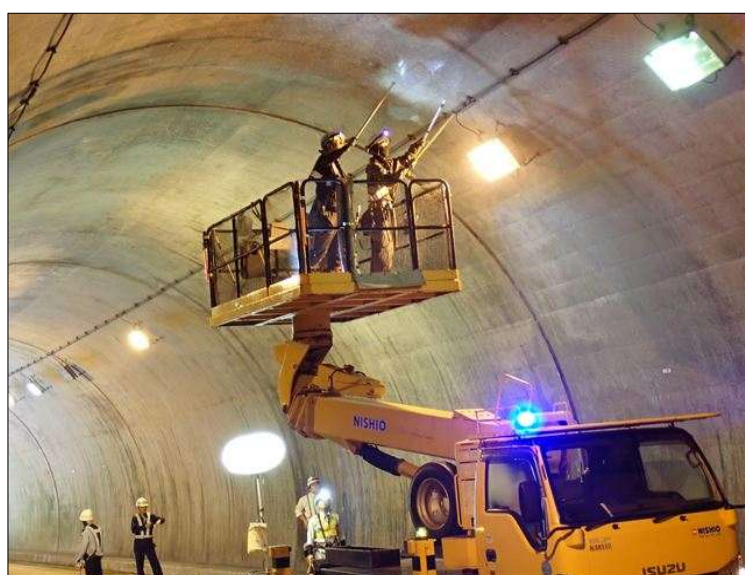
高所作業車による点検状況（内部天端部）
