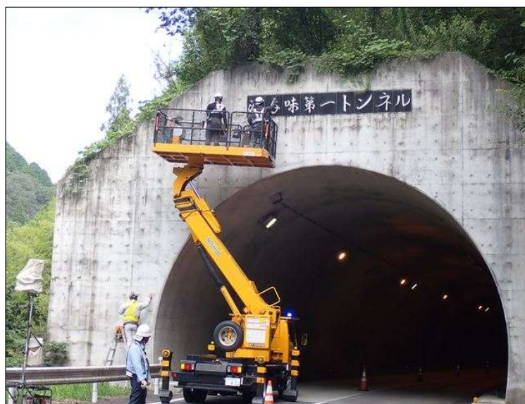
高所作業車による点検状況（坑門部）
