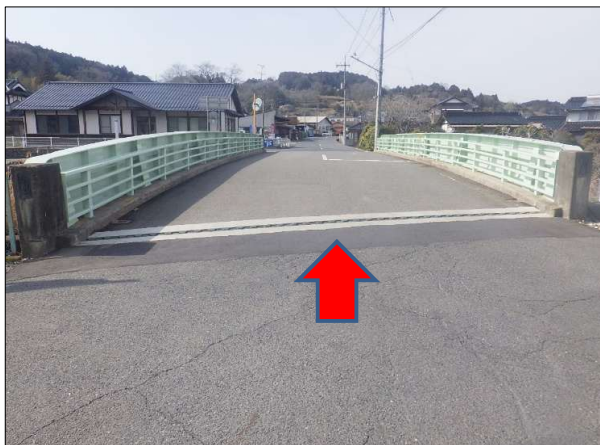
伸縮装置取替
