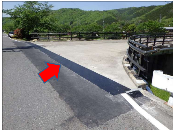
伸縮装置取替
