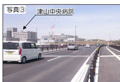
供用済区間の状況
