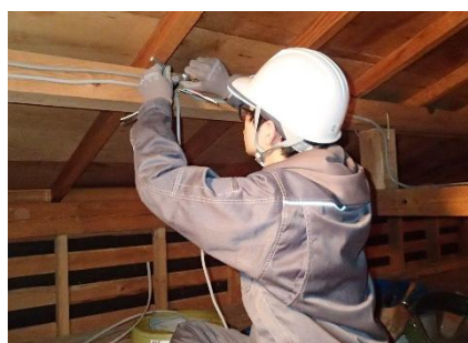
屋内配線実習
