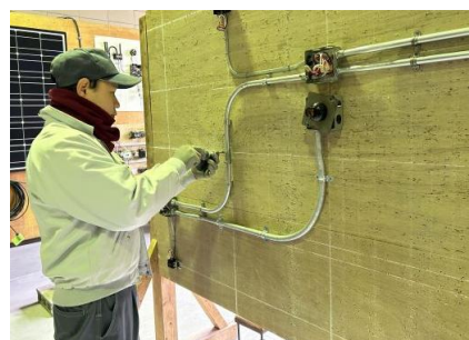
金属管工事实習
