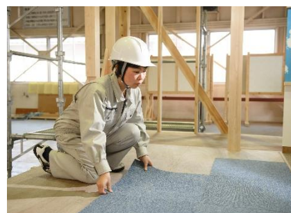
床・カーペットタイル貼り
