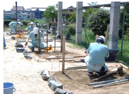
【技能検定造園工事作業3級】
