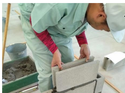
【ブロック施工】
