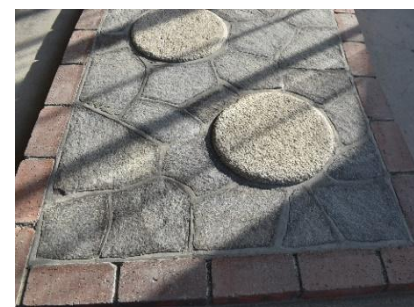
【アプローチ施工】
