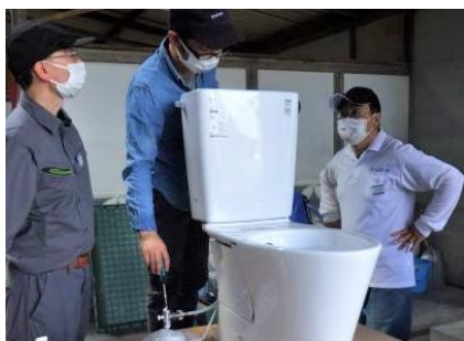
衛生器具設置
