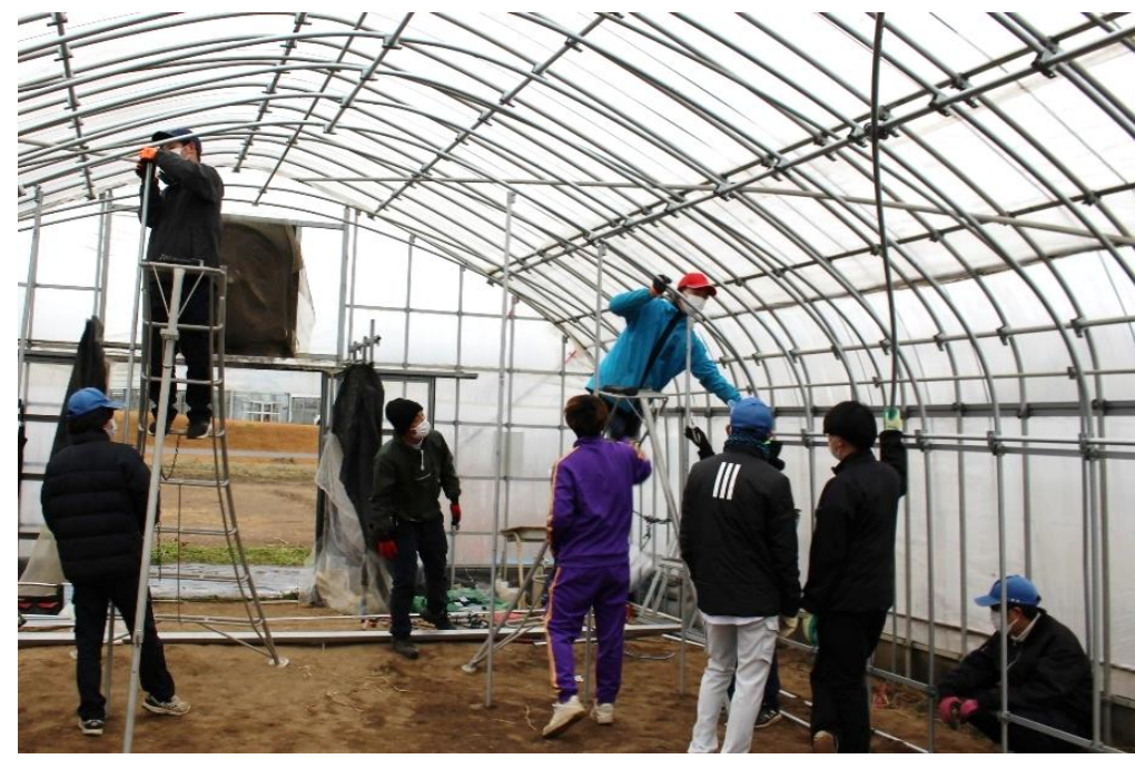
施設整備実習
