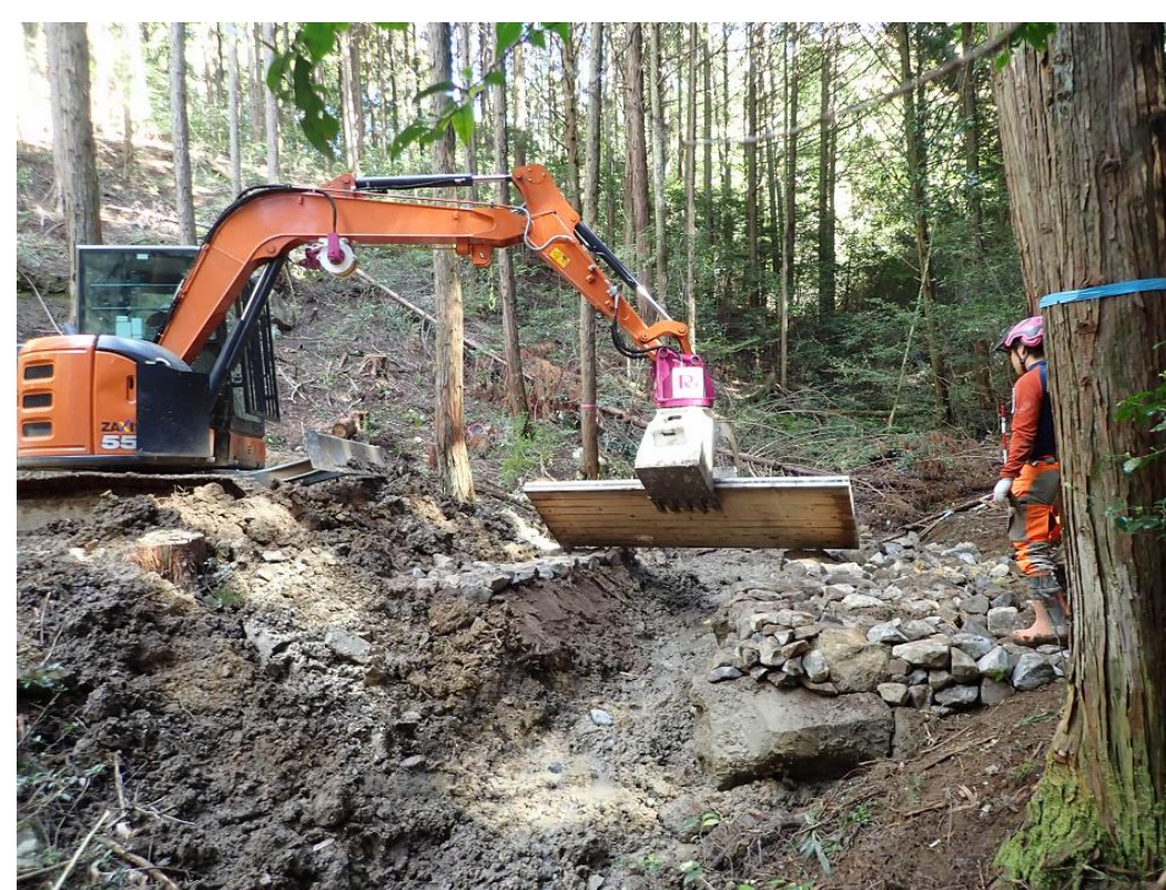
土木用CLTの設置状況
