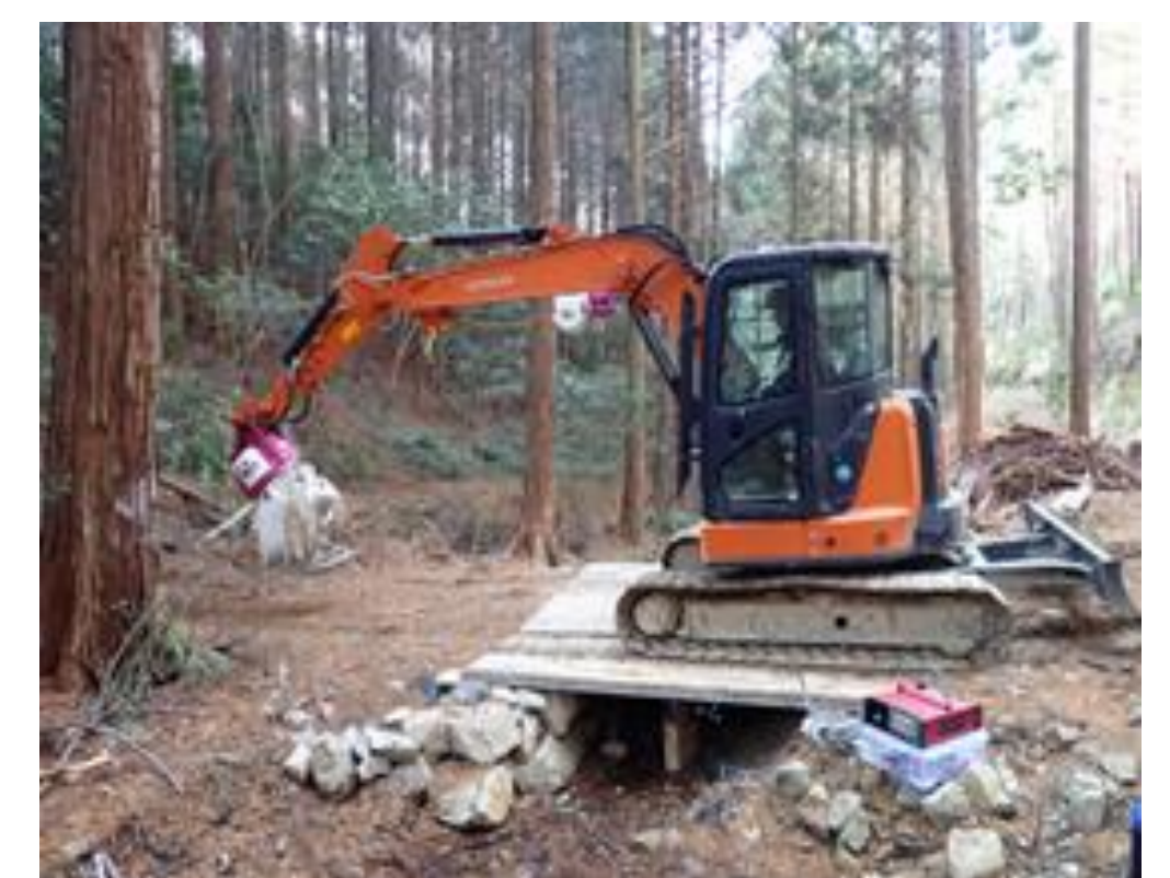
バックホウによる走行試験
