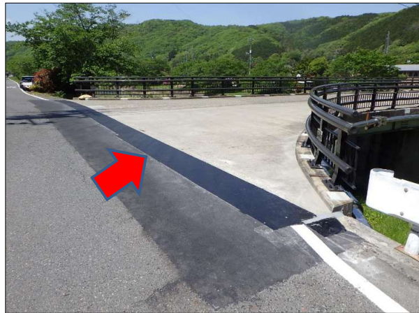
伸縮装置取替
