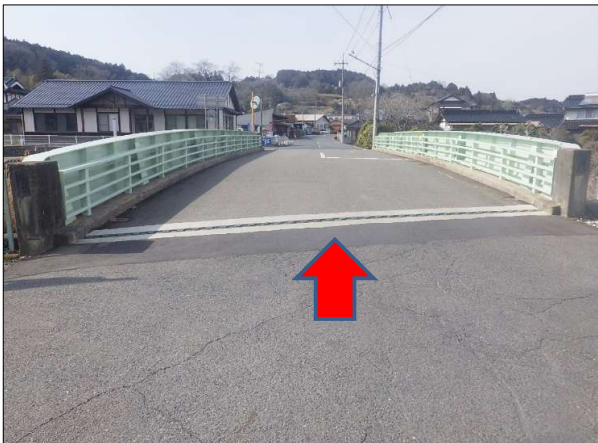
伸縮装置取替
