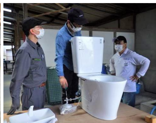
衛生器具設置
