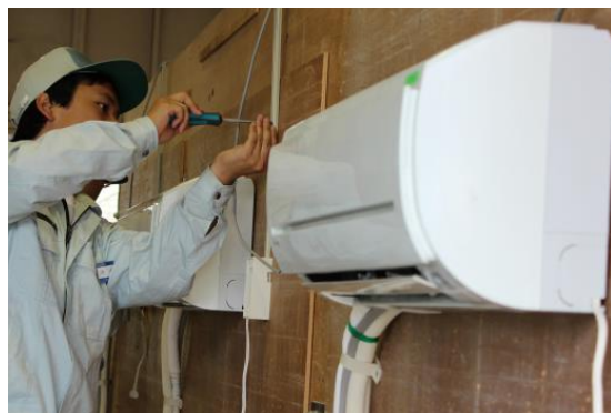
エアコン工事实習
