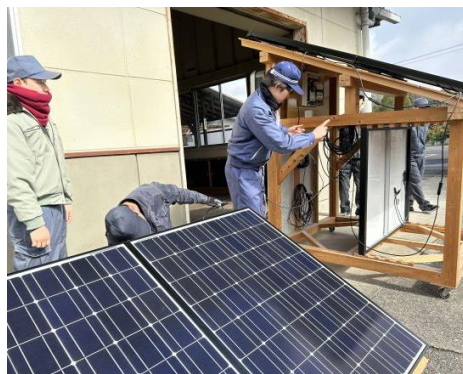
太陽光発電設備施工実習
