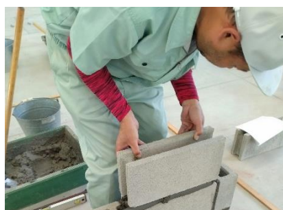
【ブロック施工】
