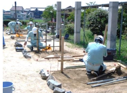
【技能検定造園工事作業3級】
