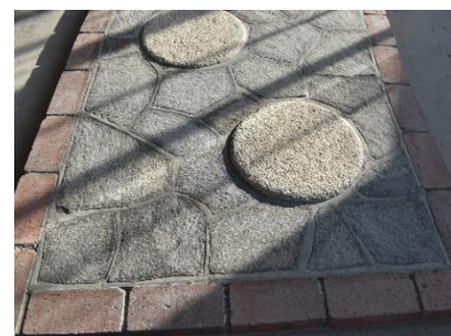
【アプローチ施工】
