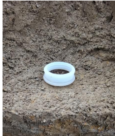
ゴムリングの取付け
