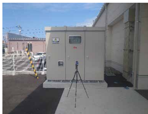
調査状況写真
