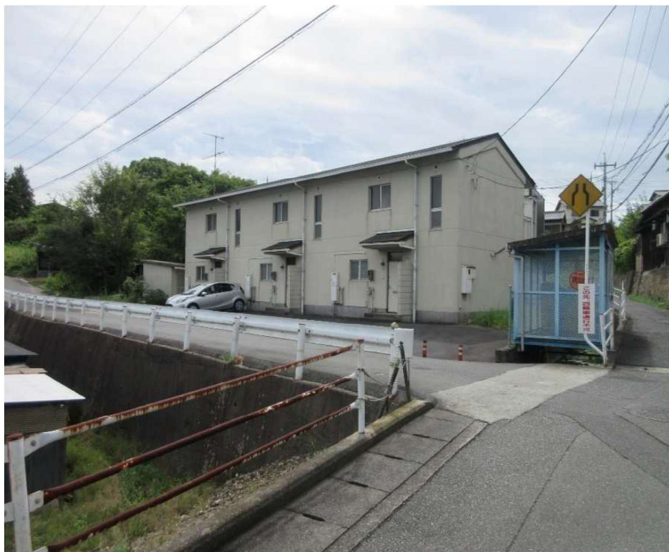
①共同住宅（北西側より撮影）
