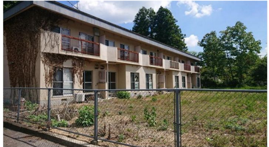
建物(2) 共同住宅
