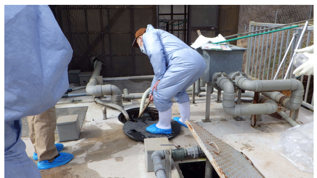
上図：浄化処理施設から採取した水を分析し、処理能力向上を図る様子
