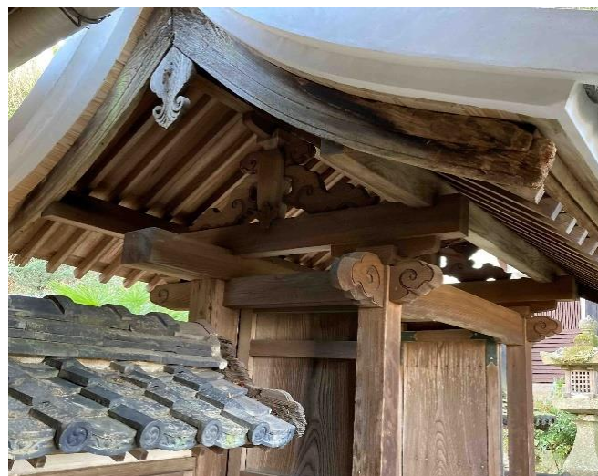
長舗家住宅内門側面 妻側
