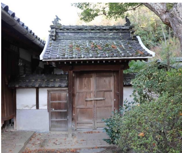
長舗家住宅内門外観
