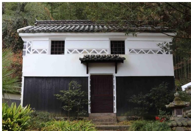
長舗家住宅内蔵外観
