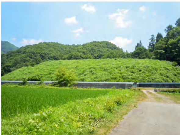
中津河大切坑捨石堆積場
