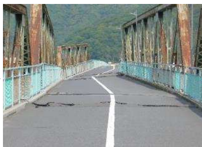
<洗掘による被災例>
